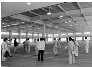
多目的屋内運動場
