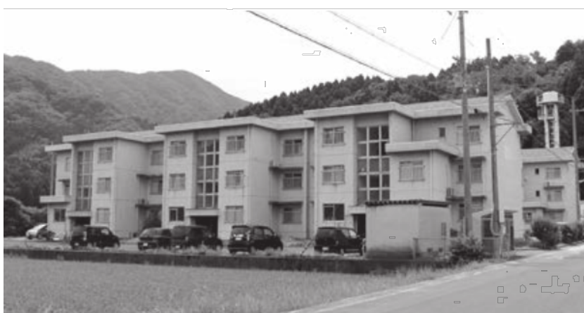
改修する小倉団地 1・2号棟
