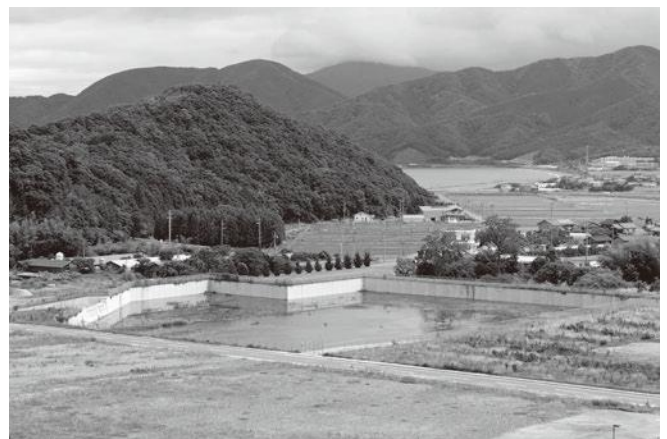
太陽光パネルが設置される産業団地調整地
