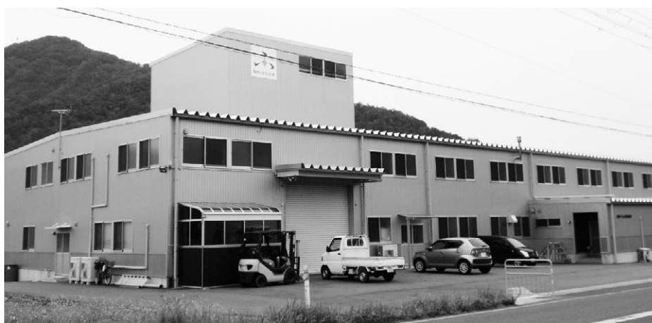
新築移設した北陸ヒーティング株式会社
