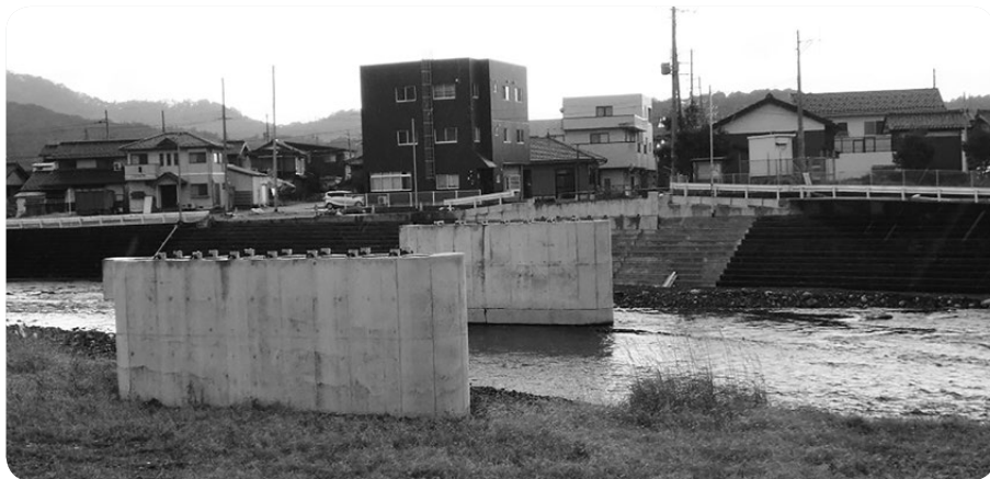
来年度中に完成予定の耳川橋（橋脚部分）
