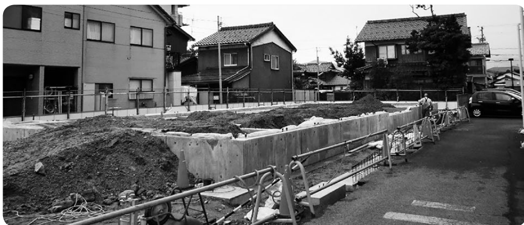
基礎工事が進む病児・病後児保育施設（敦賀市三島1）
