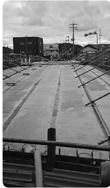
完成間近の耳川橋
