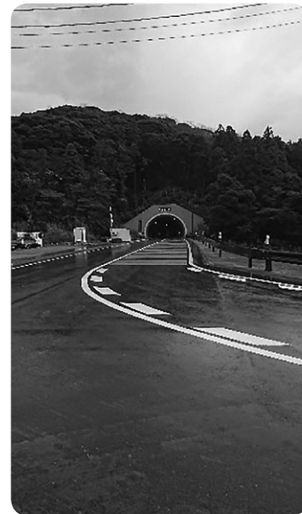
乙見トンネル付近
