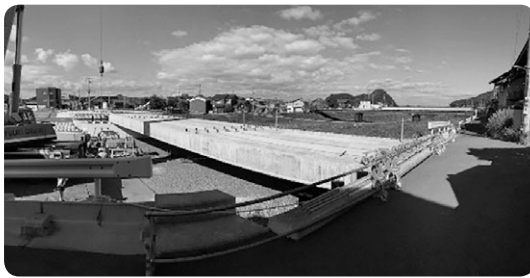
上部構造(橋桁の取付)
