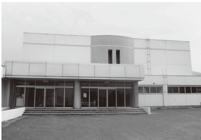
美浜中央小学校体育館
