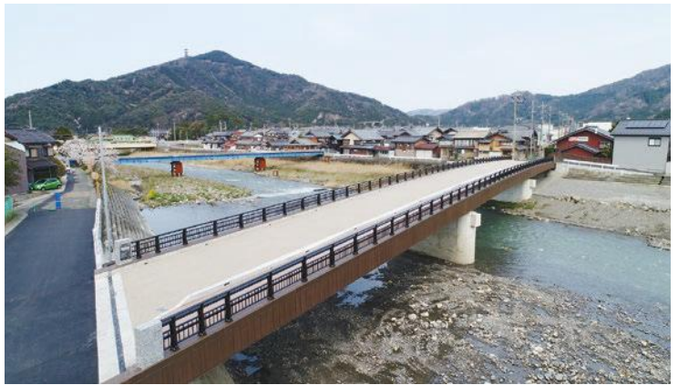
開通した耳川橋
