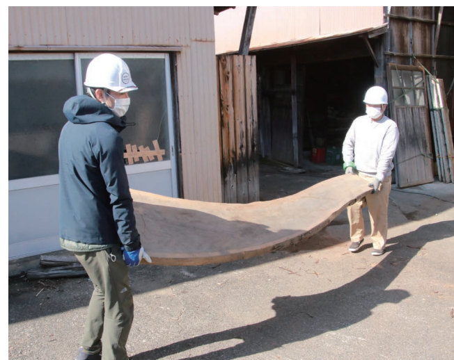
↓ 解体予定の建物から古材を運び出す参加者
