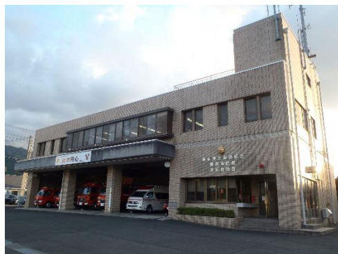
写真. 美浜消防署庁舎
