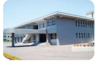
万が一、美浜発電所で事故が発生した場合の対策拠点となる「美浜原子力防災センター」は美浜町佐田（毛ノ鼻）に整備されています。
