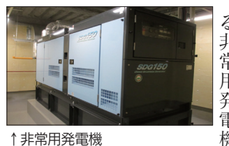
↑非常用発電機
