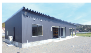
農業人材育成拠点研修施設研修棟
