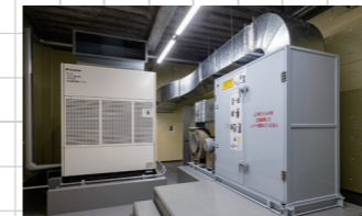
←外気を浄化して取り入れるためのフィルタリング装置
