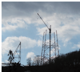
↑ 鉄塔組み立て工事
