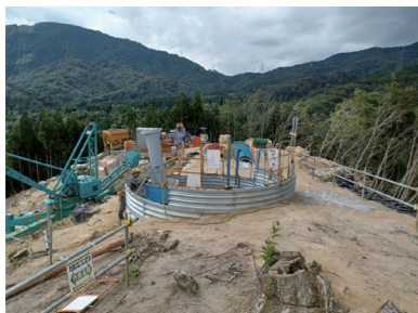
↑ 鉄塔基礎工事（新庄山間部）
