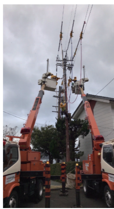
↑ 停電復旧工事
