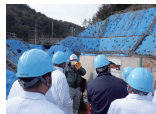
← 破砕帯の調査現場を視察する委員
