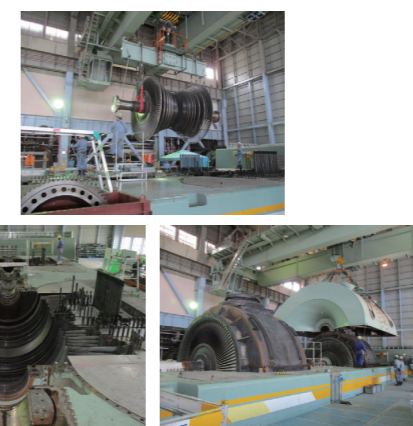
↑タービン解体の様子
