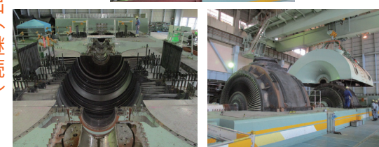
↑タービン解体の様子
