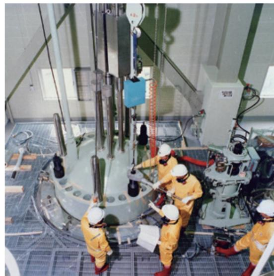
原子炉圧力容器上蓋のスタッドボルトの締付訓練をする保修員→
