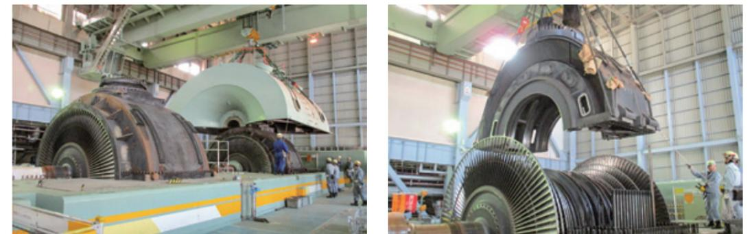
▲美浜発電所 2号機 タービン解体・撤去の様子
