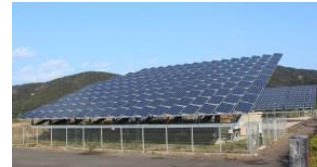
出力100kW (1基50kW) 一般家庭で使用する電力量 300kWh/月として、約47軒分の 電力量を発電しました。
