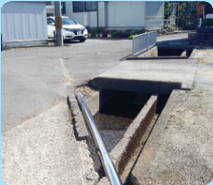
側溝開口部落下の恐れ補修要望（河原市区）
