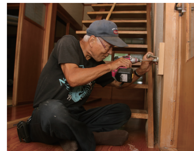
↓階段に手すりを設置する組合員
