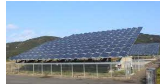
出力100kW (1基50kW) 一般家庭で使用する電力量 300kWh/月として、約11軒分の 電力量を発電しました。
