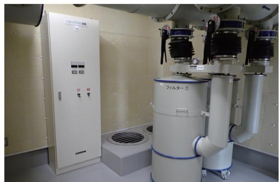
↑フィルタリングシステム制御盤（左）と放射性物質を除去するフィルター（右）
