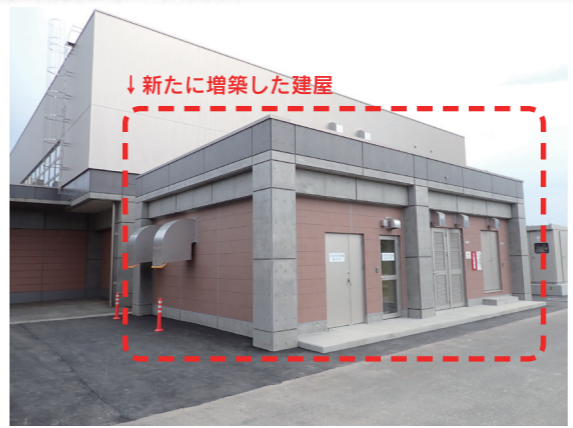
↑美浜西小学校体育館
