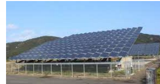
出力100kW（1基50kW） 一般家庭で使用する電力量300kWh/月として、約39軒分の電力量を発電しました。
