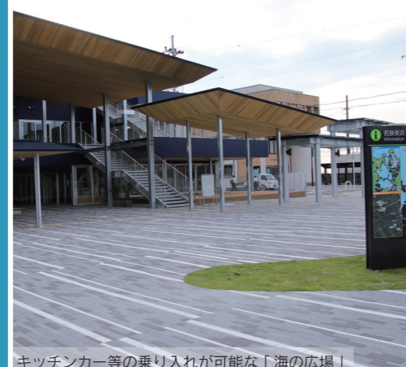
キッチンカー等の乗り入れが可能な「海の広場」
