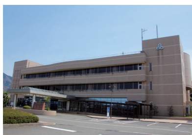
↑改修工事を行う町役場(庁舎)
