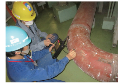
↑配管の肉厚測定
