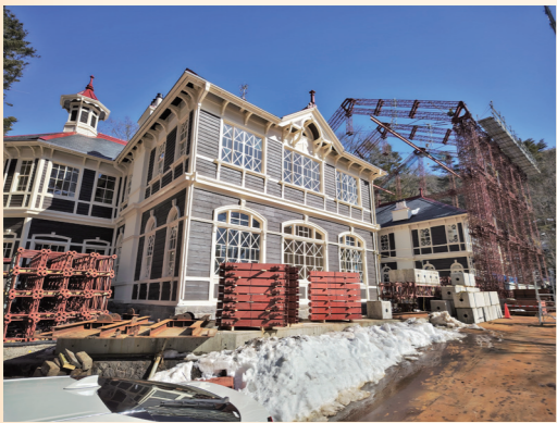
↑修理工事中の旧三笠ホテル(2月現在、令和7年初夏公開予定)
