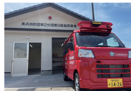
↑配備された小型動力ポンプ付軽積載車と完成した消防団器具置場（詰所）
