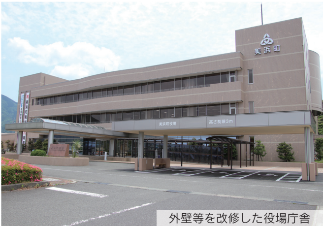
外壁等を改修した役場庁舎
