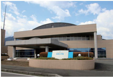
↑改修工事を行うはあとびあ
