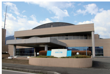
↑改修工事を行うはあとびあ
