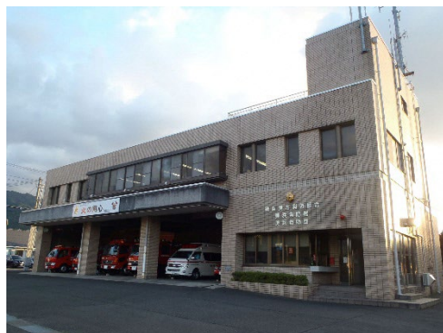
写真. 美浜消防署庁舎
