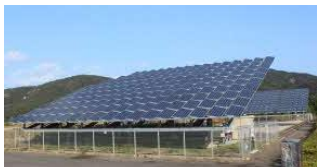
出力100kW (1基50kW) 一般家庭で使用する電力量300kWh/月として、約29軒分の電力量を発電しました。
