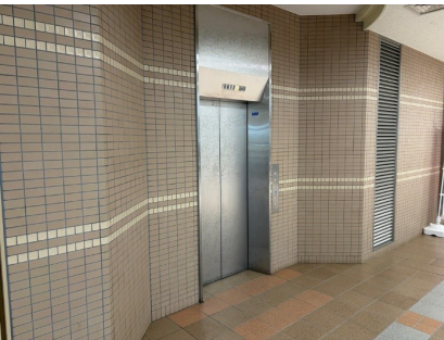
↑改修工事を行うエレベーター
