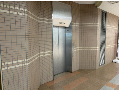
↑改修工事を行うエレベーター
