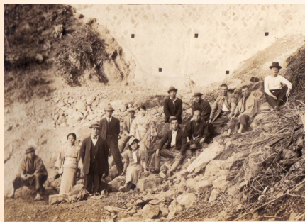
↑立岩にて砂防堰堤第一工事竣工の図（昭和10年（1935））
