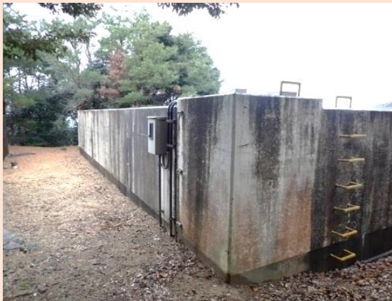
耐震化が必要な竹波配水池
