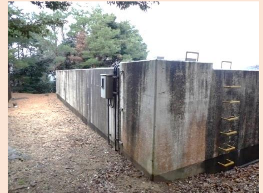
耐震化が必要な竹波配水池
