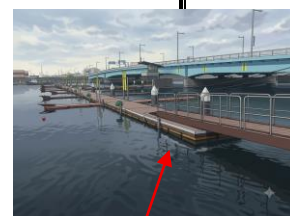
スタートポンツーン
