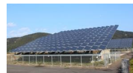
出力100kW (1基50kW)
