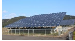
出力100kW (1基50kW)
